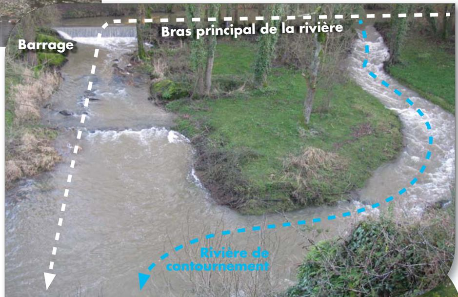
**Création d'un radier\*** permettant l'accélération du courant, l'oxygénation de l'eau, le maintien d'un lit d'étiage\* et l'aménagement d'un accès pour les pêcheurs (commune de Chaudfonds-sur-Layon).
