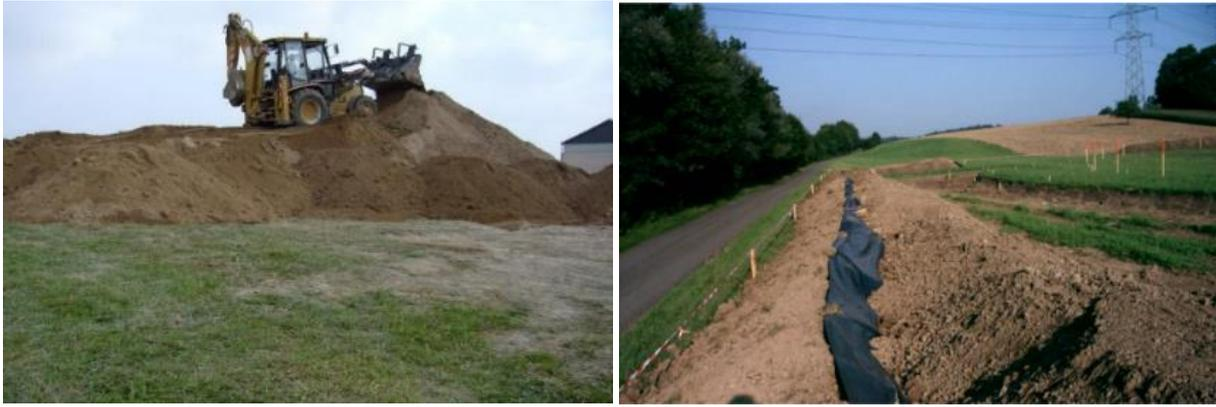
Compaction néfaste de la terre par les machines - Stockage de la terre correct
