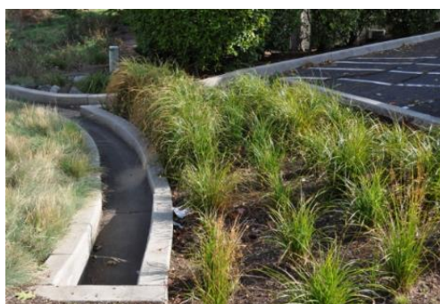
Utilisation de la pente pour arroser un parterre et canal pour le trop-plein d'eau
