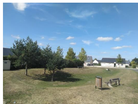
Un bassin d'orage par temps sec (Terranjou)
