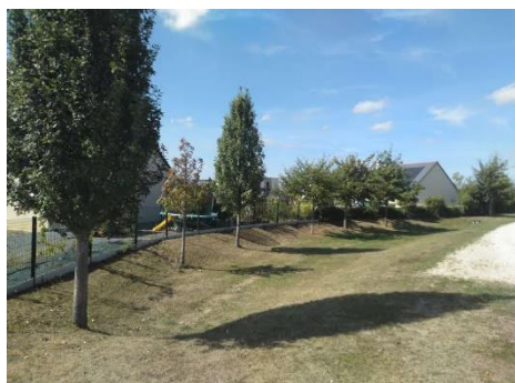
Système de noues. Eviter les barrières de bois, les pierres et une forte pente. (Martigné-Briand)
