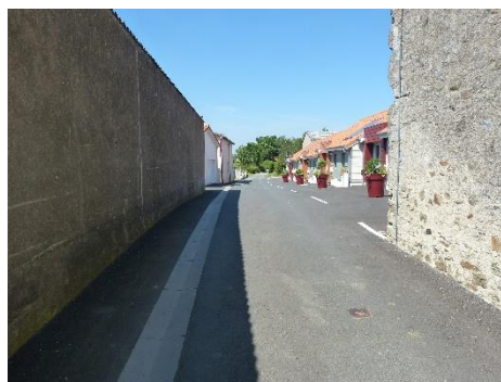
Voirie partagée permettant d'orienter les eaux de pluie (Doué-en-Anjou)
