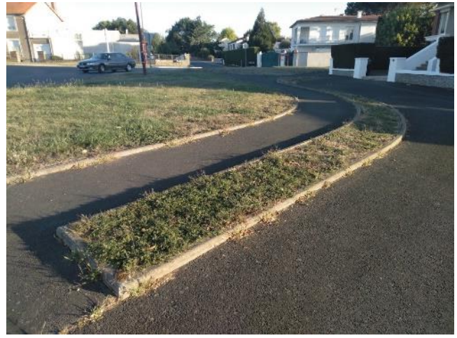
Bordures surélevées compliquant la tonte d'espaces enherbés très étroits (Beaupréau-en-Mauges)
