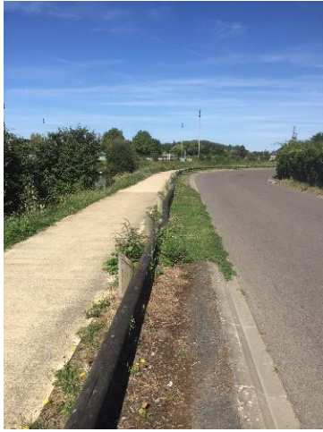
Chemin en sablé et trottoir bétonné adjacent, envahi par les adventices (Doué-en-Anjou)
