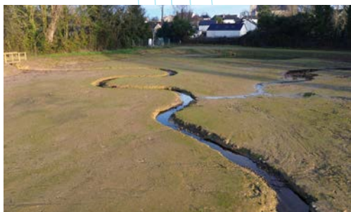
Après travaux, effacement des lagunes, cours d'eau méandrique et zone humide. Réduction du gabarit du cours d'eau.
