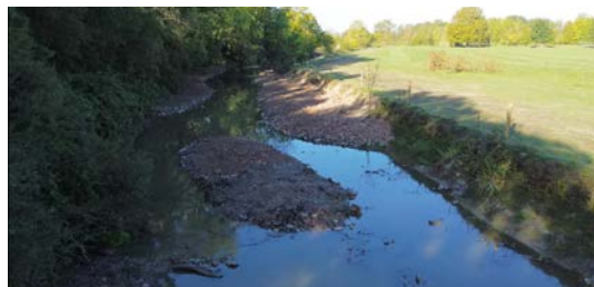
Après travaux : recharges en granulats
