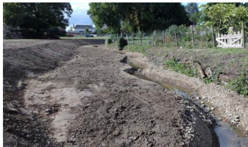
Berge décaissée pour permettre le débordement et création d'une sinuosité du lit (pendant travaux)
