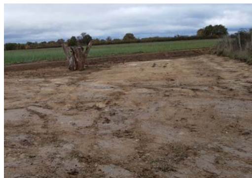
Zone tampon avec noue d'infiltration et talus en vue d'une plantation
